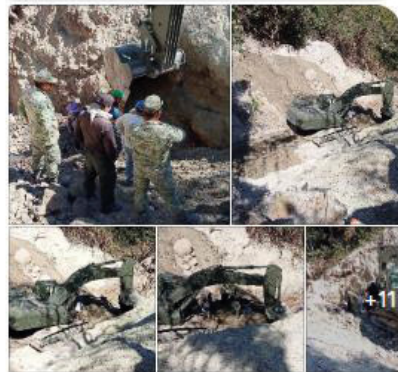
Excavación. Se observa a peritos e ingenieros operadores de maquina para la extracción de una gran roca.
