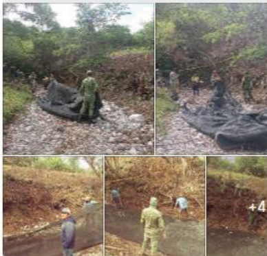
Rastrilleo y retiro de sedimento
