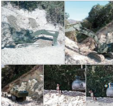
Vista desde superficie del trabajo en excavación.
