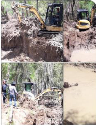
Ampliación de la excavación de 5x9 mts en el sitio de interés
