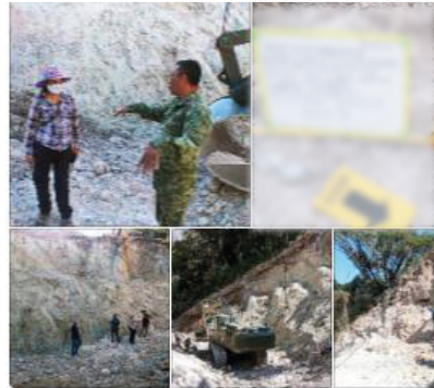
Peritos observando el área y dando indicaciones a maquinista antes del inicio de la excavación.
