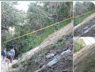
Reconocimiento al fondo de la barranca para observar el paso de la excavadora con orugas.
