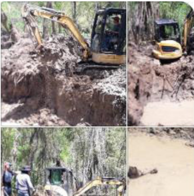
Acondicionamiento del terreno para el empleo de la miniexcavadora.
