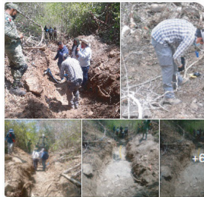
Cala realizada en el área. Se
